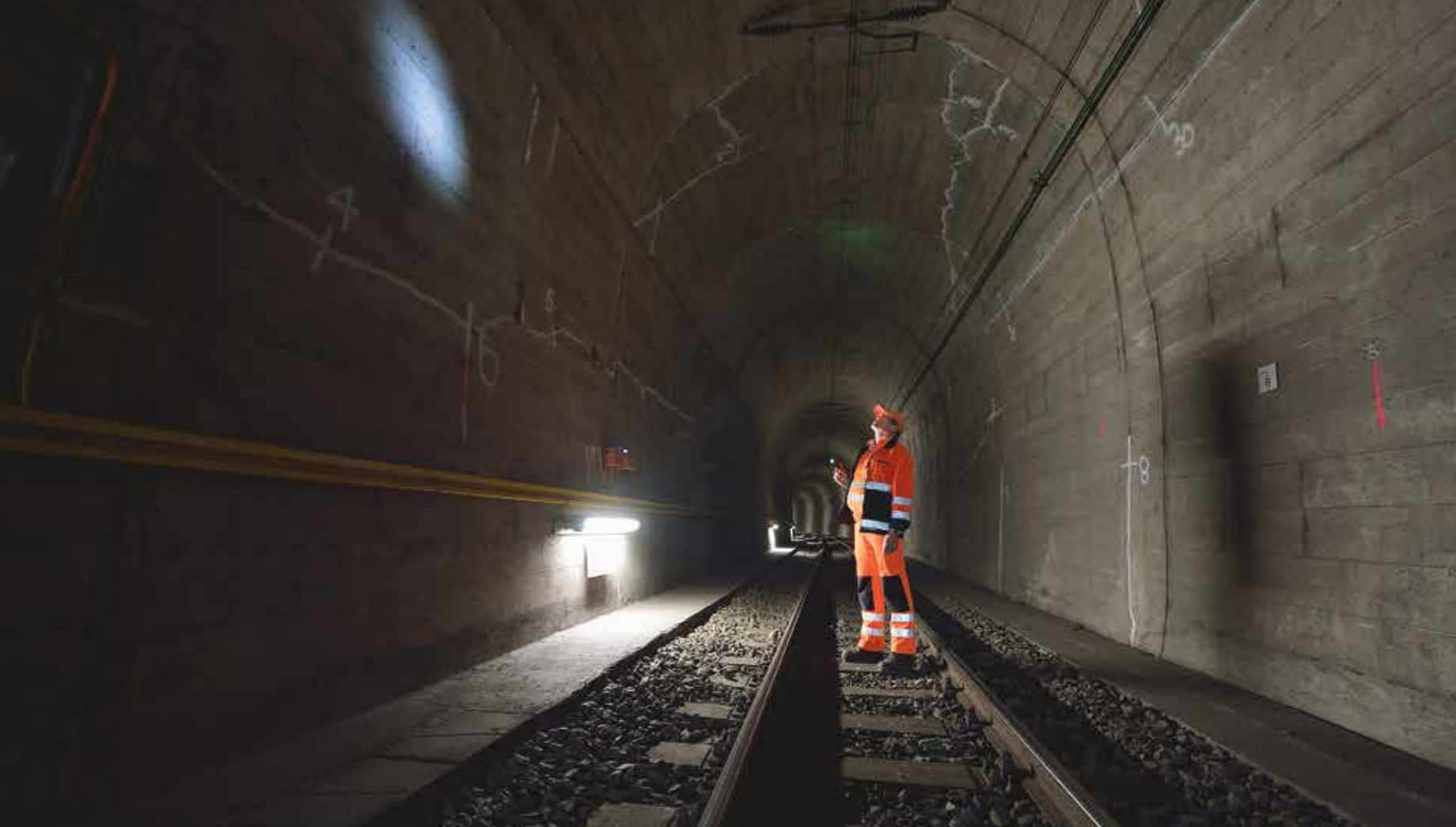
Röhren-Check: Armin Mathis kontrolliert im Loppertunnel auch den Zustand der Gewölbemauern.
