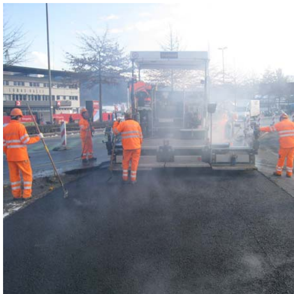
Belagsarbeiten auf der umgelegten Horwerstrasse.
