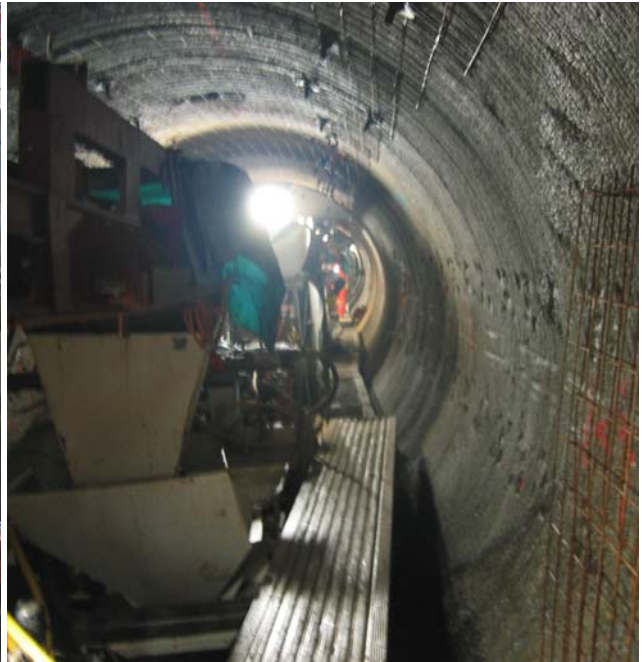
Blick in den Pilotstollen.
