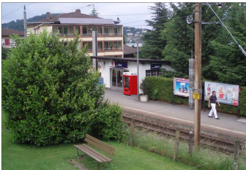
Die Haltestelle Hergiswil Matt: Gemäss Ausbauprojekt wird sie neugestaltet und behindertengerecht erschlossen.
