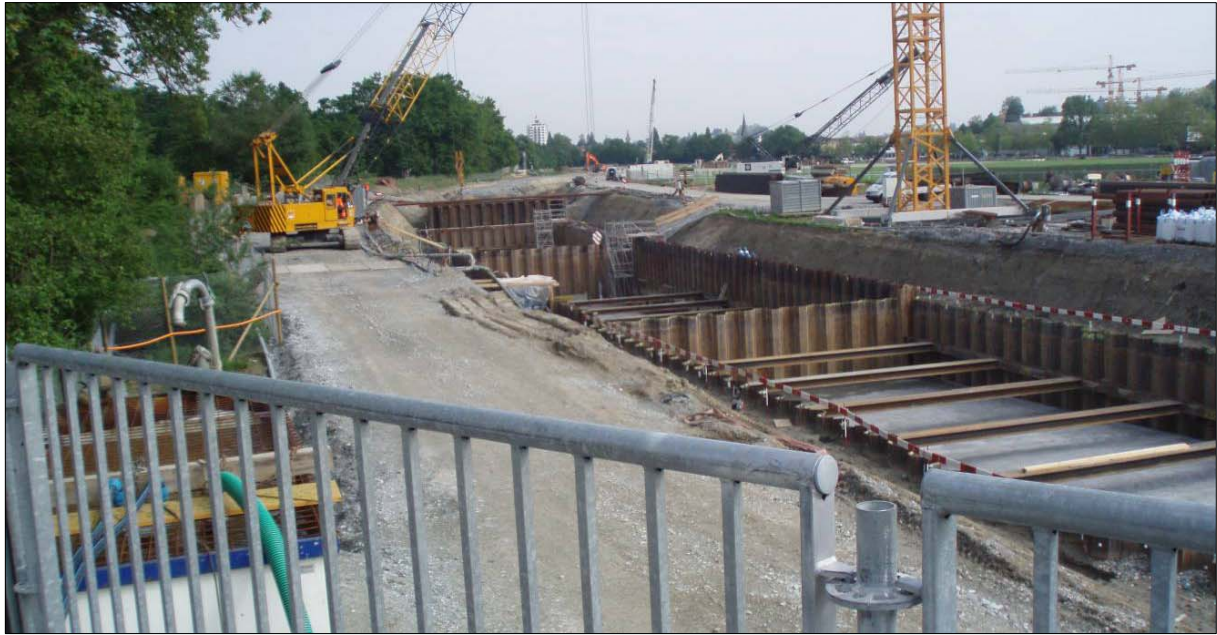
Blick von der Plattform Mattenhof auf die Erstellung der zukünftigen Rampe.
