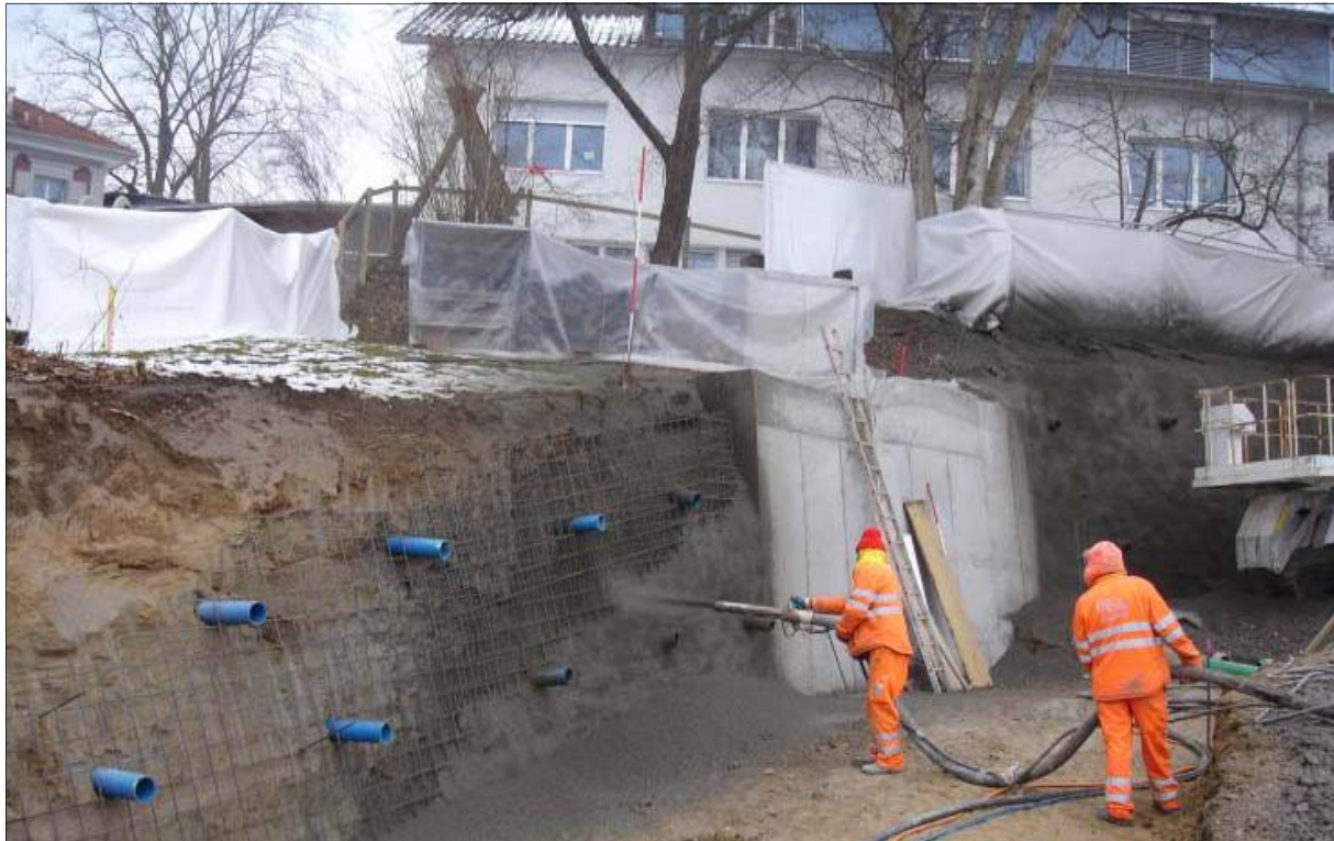
Arbeiten am Südportal des Hubelmatattunnels.
