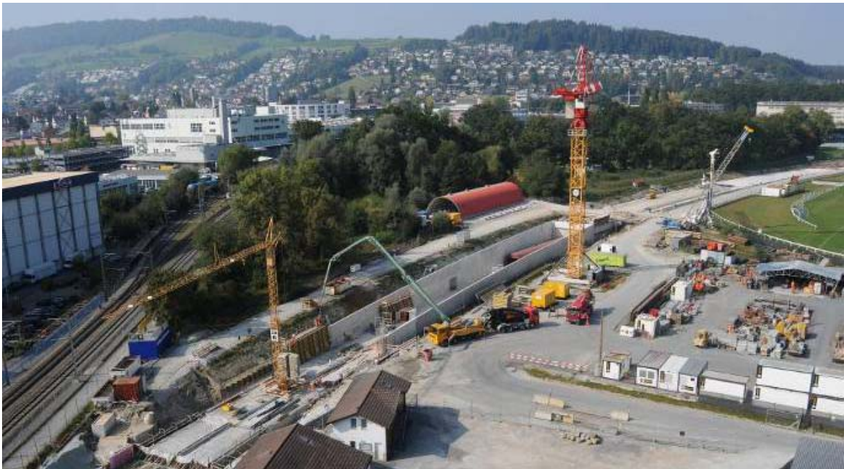
Baustelle Tunnel Allmend, Rampe Mattenhof.
