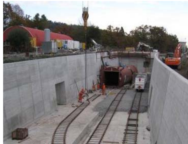
Rampe Mattenhof, Materialschleuse.
