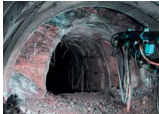
Vergrösserung des Tunnelprofils zum Einbringen einer druckfesten Betonschale.
