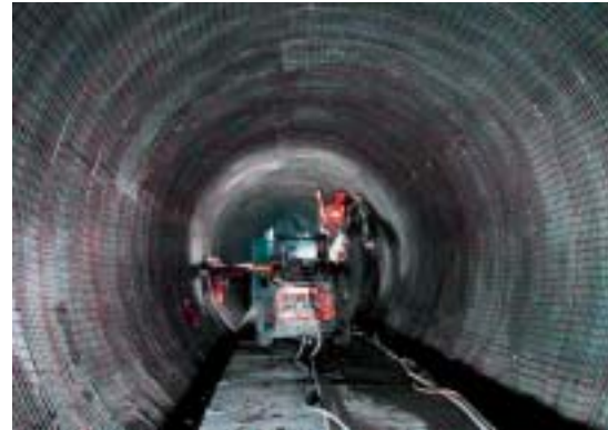
Die gänzlich ausgekleidete Wassereinbruchsstelle bei Tunnelkilometer 1955.
