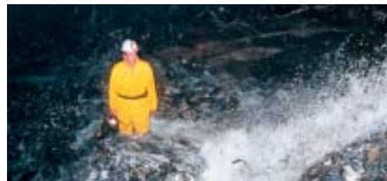
Sowohl das Titelbild als auch diese Aufnahme zeigen die enormen Ausmasse der Wassereinbruchsstelle, welche im Sommer 2003 den Tunnelvortrieb ein weiteres Mal zum Erliegen brachte.
