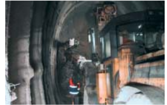
Im Tunnel Nord kommt der Vortrieb wieder planmässig voran.
