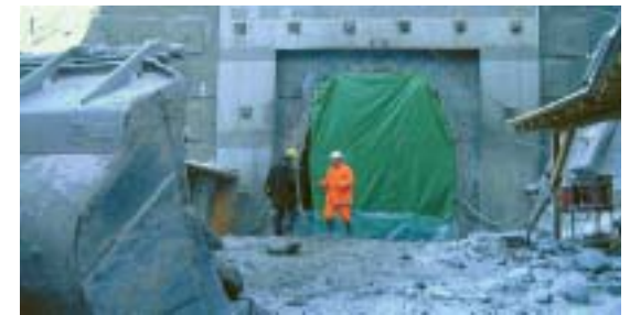
Das Portal Süd wird zur Zeit ausgestaltet und fertiggestellt.
